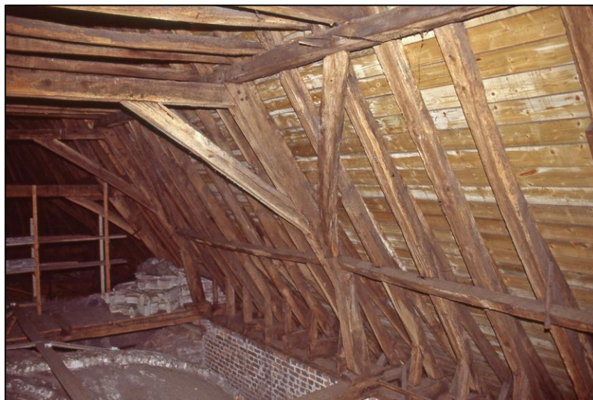
In het verleden gerestaureerde kap. Op het dakbeschoot een witte uitslag van het inmiddels verboden bestrijdingsmiddel lindaan.
